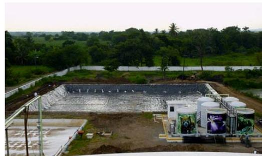
El agua que se genera en la limpieza de los equipos de fábrica y la limpieza de algunas áreas en piso, se capta y es tratada mediante la recirculación de lodos activados para reducir la demanda bioquímica de oxígeno (DBO), el monitoreo se realiza mediante análisis realizados por un laboratorio certificado.
